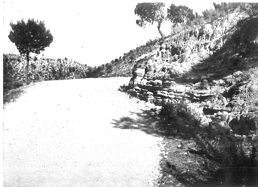
Estratos de arenisca helveciense en el Km. 51 de la carretera de Cieza a Mazarrón (B-1).
